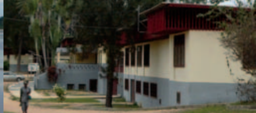
Links: das Ufer des Ogowe heute. Rechts: Gebäude des heutigen Hospitals.
